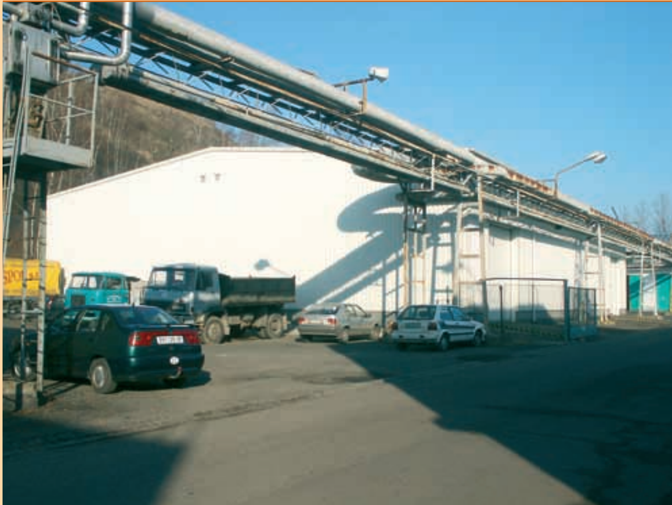
K projektu „Výstavba lakovny a komaxitovny v Ostravě – Přívoze“
